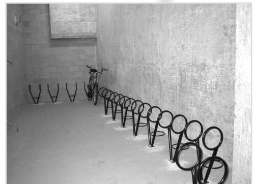
Stationnement intérieur pour les bicyclettes chez BC Housing à Burnaby, C.-B.
