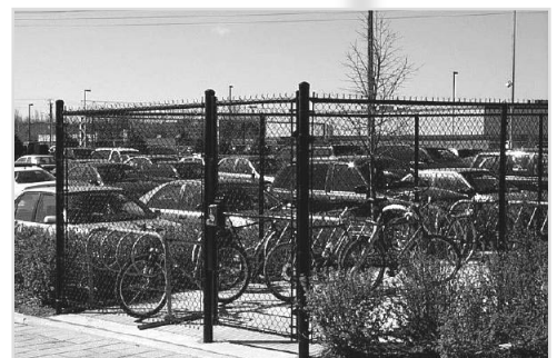
Stationnement extérieur pour les bicyclettes chez Nortel Networks à Ottawa, Ont.
